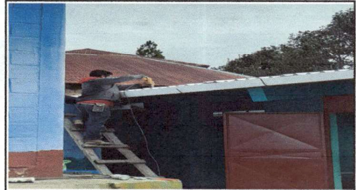
Foto 4: Cambio Canales de agua.
