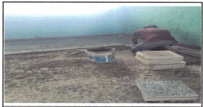
Foto 6: Sustitución de piso de granito.
