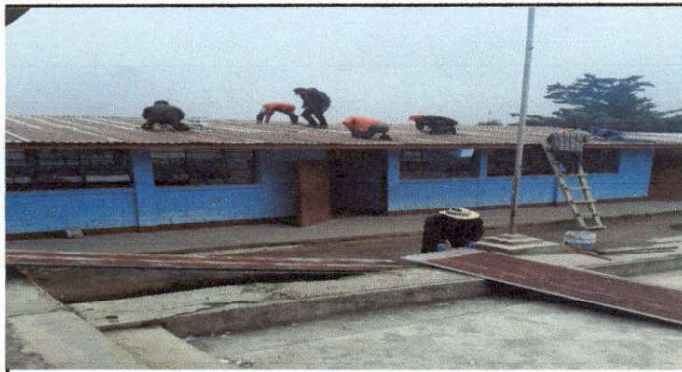
Foto1: Cambio de lámina por lámina troquelada aluzinc calibre 26.
