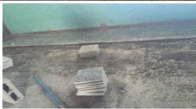
Foto 3: Sustitución de piso de granito.
