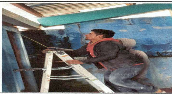
Foto 5: Cambio de bajadas de agua.
